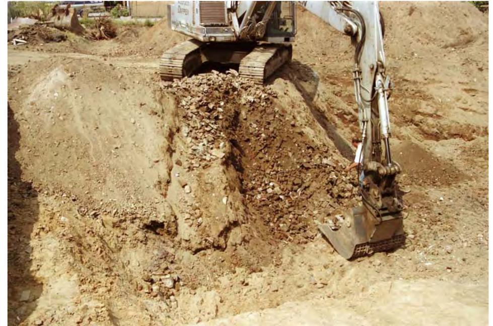
**Baugrube mit schuttdurchsetztem Boden ausgesiebt – Neuss Dirkes
