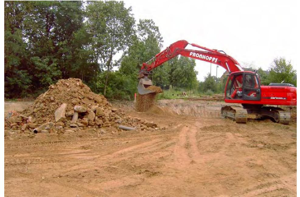
**Baugrube mit 10.000 m<sup>3</sup> schuttdurchsetztem Boden ausgesiebt – Flughafen Düsseldorf
