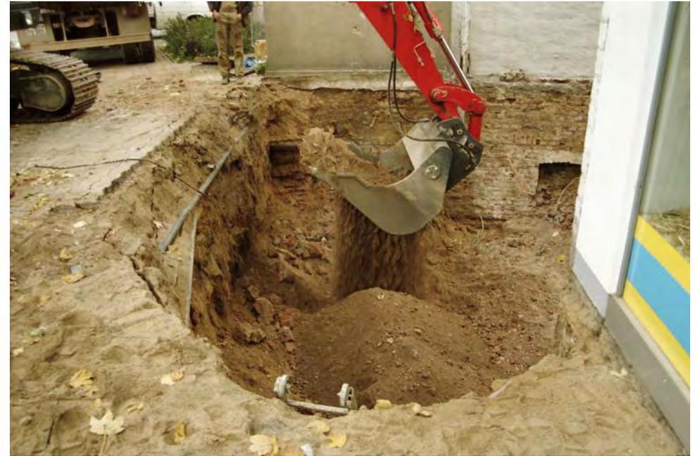
**Baugrube mit schuttdurchsetztem Boden ausgesiebt - Neuss**
