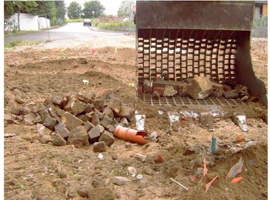
**Baugrube mit schuttdurchsetztem Boden ausgesiebt – Neuss Gohr**
